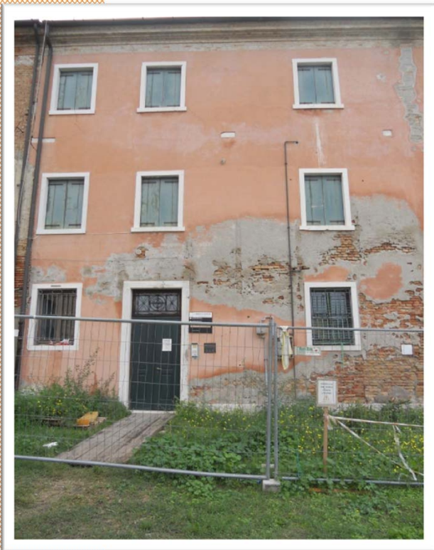
003-vista prospetto ovest
