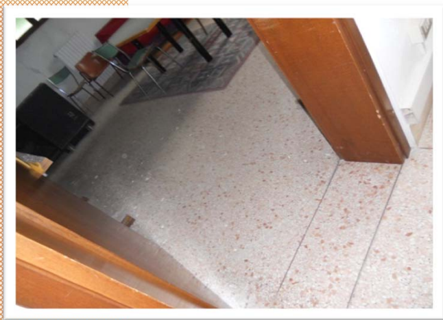
017-vista pavimento interno
