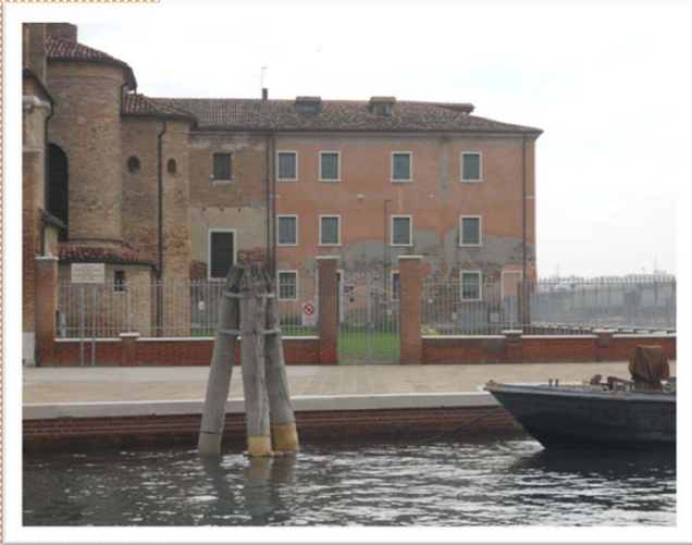
001-vista prospetto ovest
