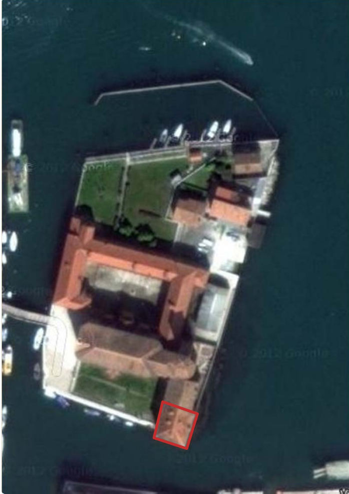
Provincia di Venezia Comune di Chioggia 017_Edificio Ex Lazzaretto Fondamenta di San Domenico
